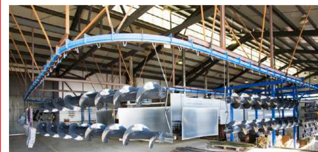
Instalación pintura en polvo
